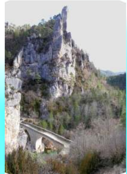
Puente de Peñalén
